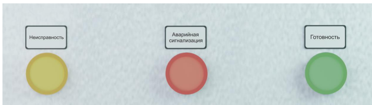
Рис. АПС. 8. Световая индикация шкафа БАВР
